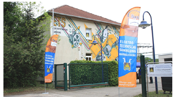
ETS Markkleeberg, Mönchereistr. 2, Eingangsbereich
