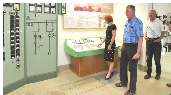
Besichtigung neue Schaltwarte in Markkleeberg
