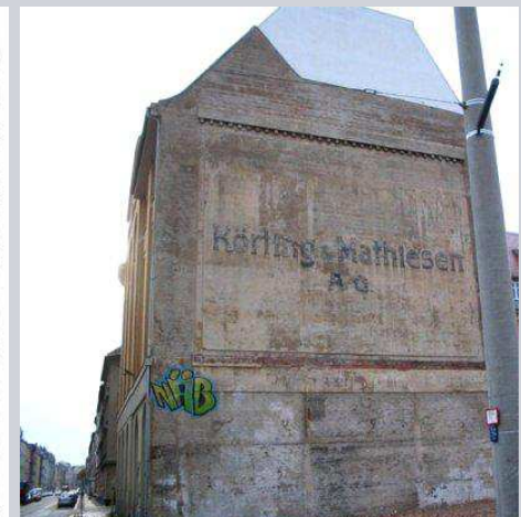
Freigelegte Ansicht-K&M Werk, Leutzsch 2004
