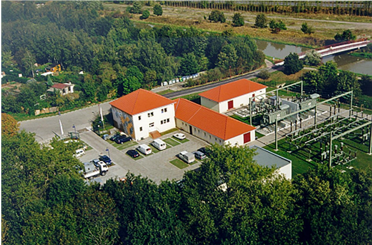
Die elektrotechnische Sammlung und das Umspannwerk Markkleeberg
